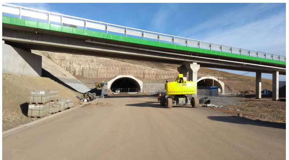
Południowy wylot dłuższych tuneli
