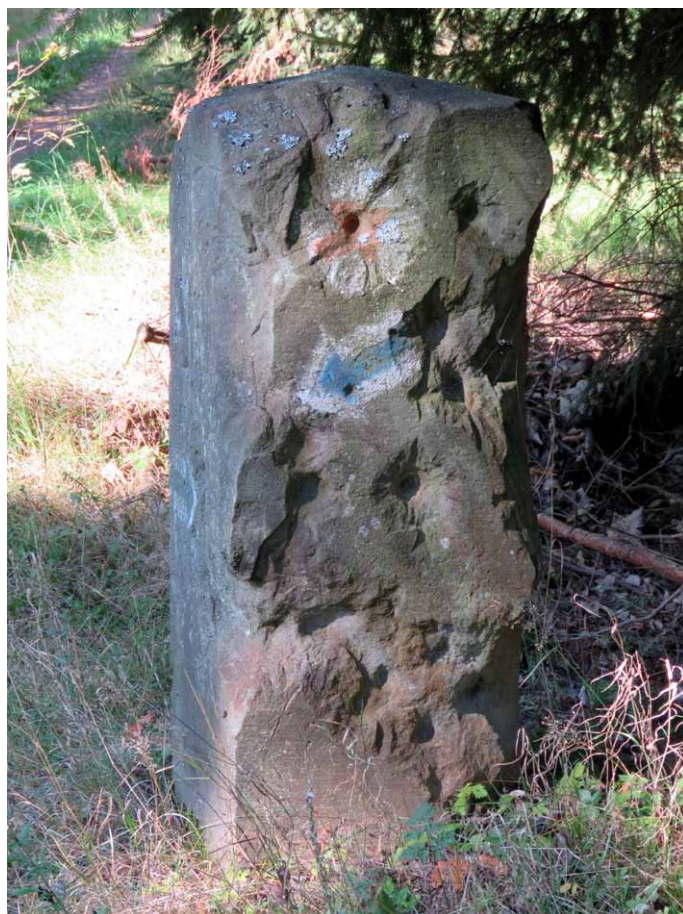
Zniszczony bok kamiennego drogowskazu
