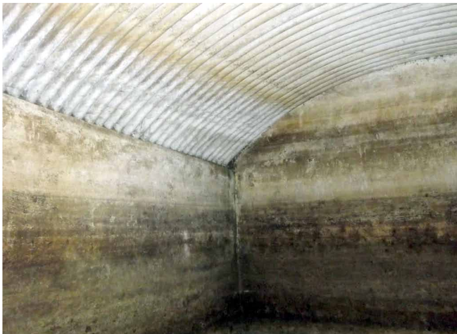
Wnętrze amunicyjnego schronu nr 9
